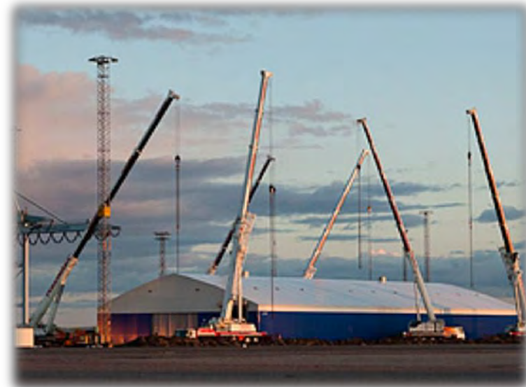
Перемещение ангара без демонтажа
